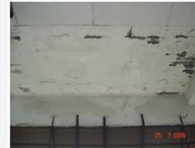
**Ketebalan selimut beton kurang sehingga mempercepat proses korosi**
